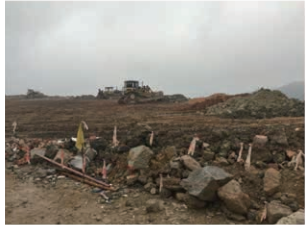
圖2.3-8 堆填區用小型挖掘機碾壓
