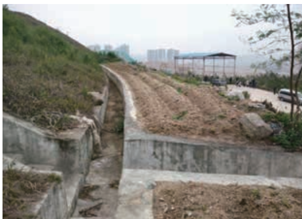
圖2.2-3 受納場水平和縱向排水溝
