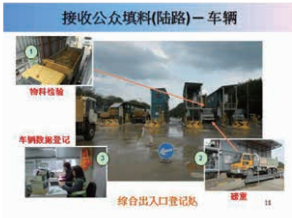
圖2.3-3 填料庫入口登記檢驗處一
